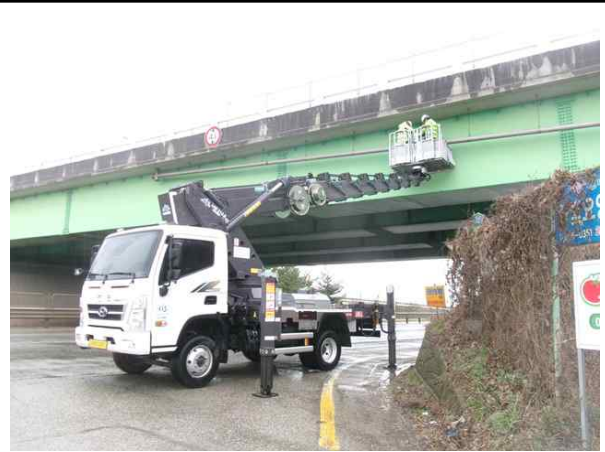
고소작업차를 이용한 근접조사
