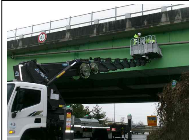
고소작업차를 이용한 근접조사
