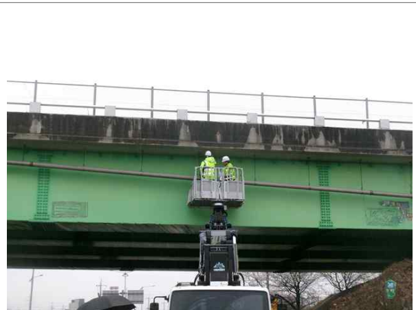
고소작업차를 이용한 근접조사
