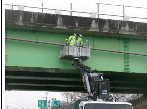
고소작업차를 이용한 근접조사
