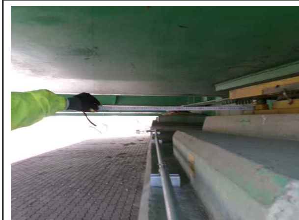
받침장치 연단거리 측정
