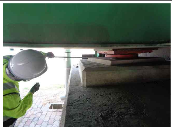
받침장치 연단거리 측정
